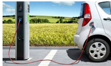
SERVICIO DE CARGA ELÉCTRICA PARA AUTOMÓVILES
